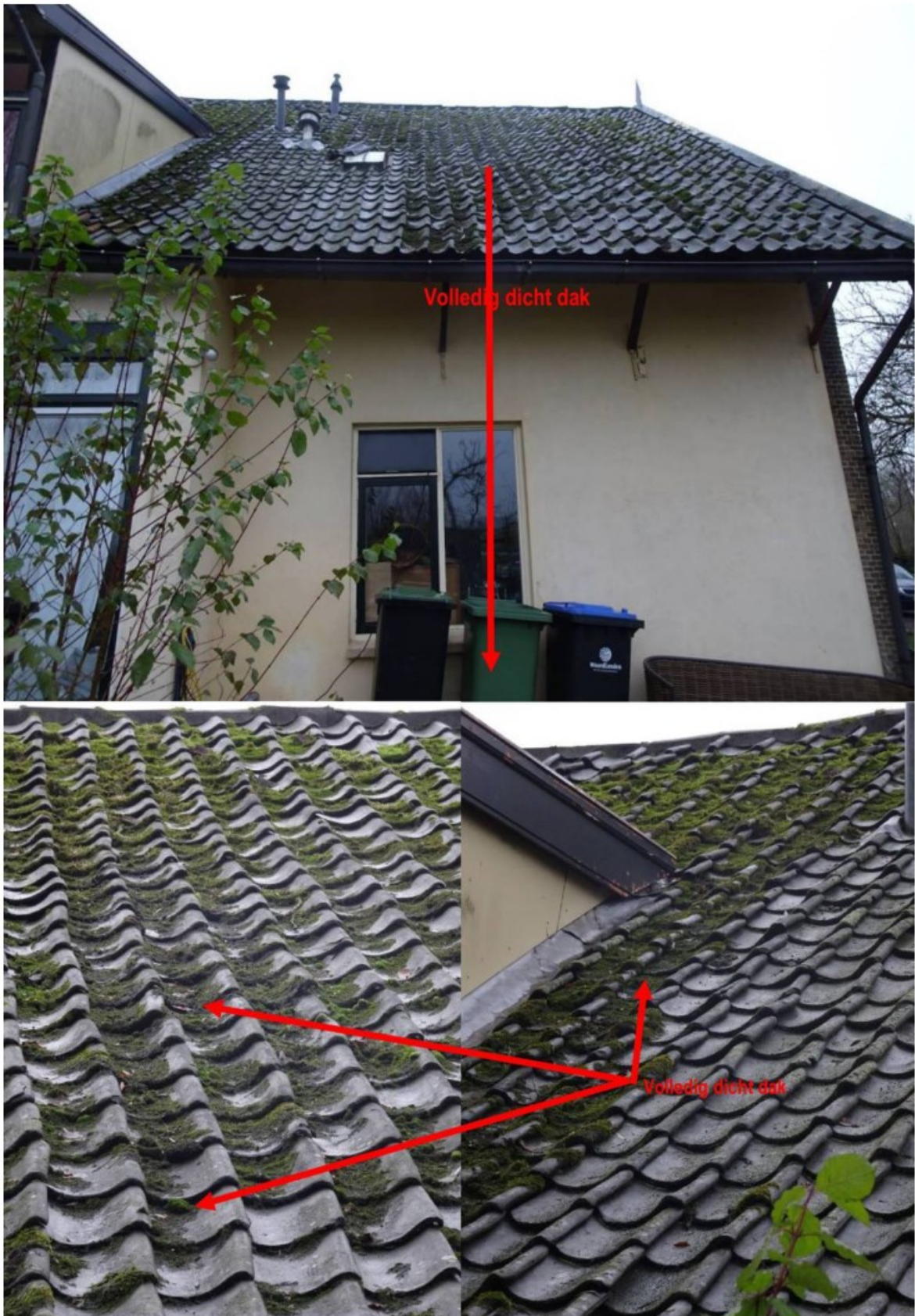
Vervolg figuur 4. Geen potentiële verblijfplaatsen voor vleermuizen en gierzwaluwen in het plangebied aan de Heulenslag 25 te Bleskensgraaf.
