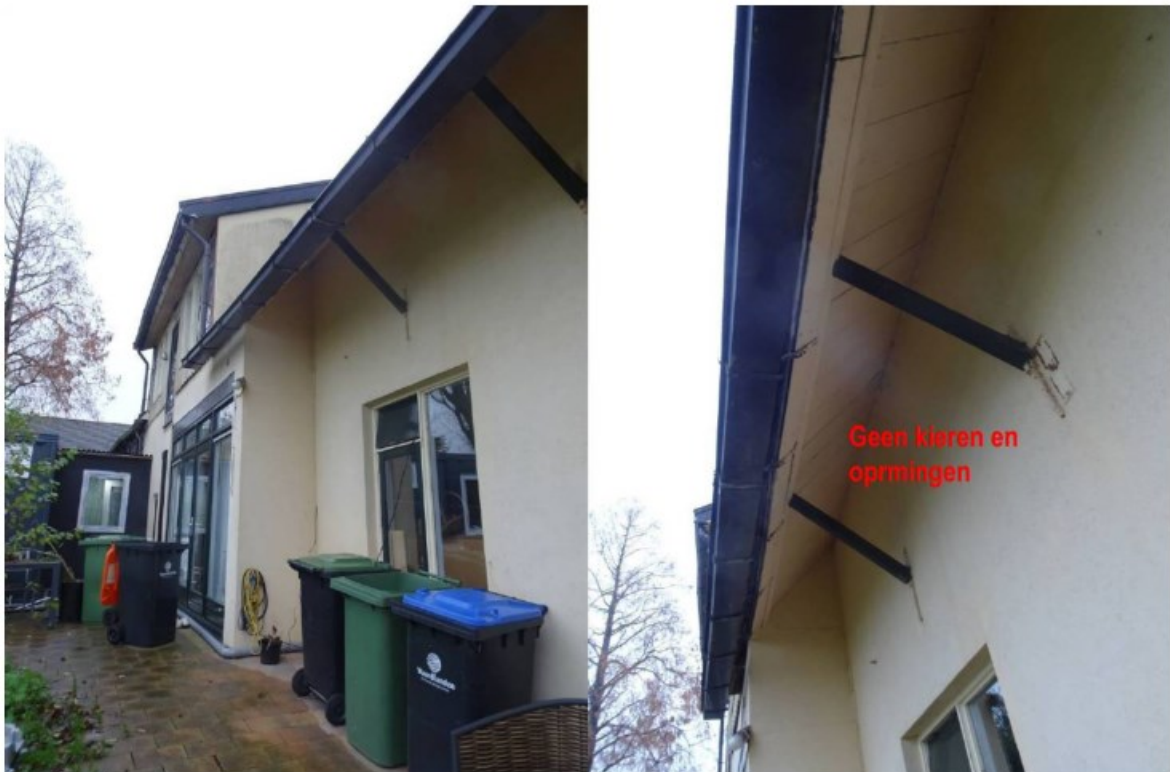
Figuur 5. Geen potentiële verblijfplaatsen van vleermuizen in het plangebied aan de Heulenslag 25 te Bleskensgraaf doordat er geen openingen en gaten zijn waarin vleermuizen zich kunnen ophouden.
