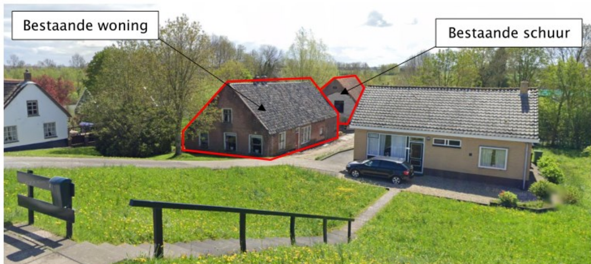
Afbeelding 3: Vooraanzicht bestaande situatie Lekdijk 132 Langerak
